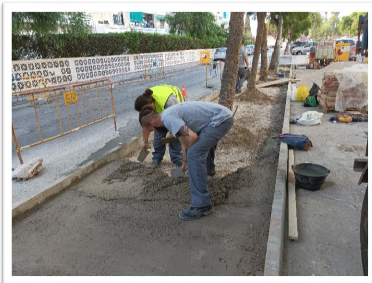
TRABAJOS PRÁCTICOS ARREGLO ACERADO AVDA. BEJAR
