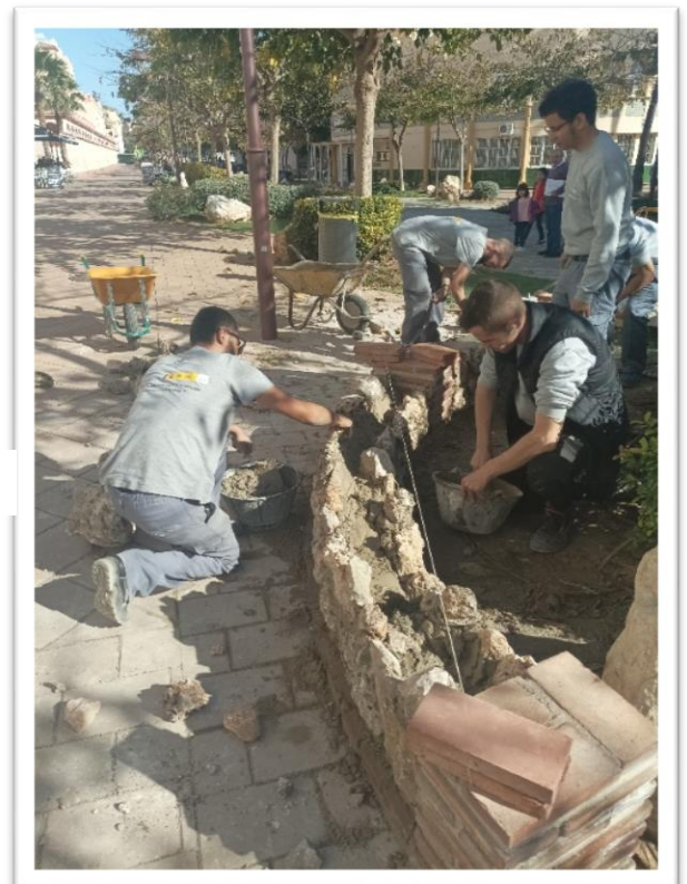
PRÁCTICA EN PIEDRA Y LADRILLO VISTO EN BANCO PASEO DEL GENERALIFE
